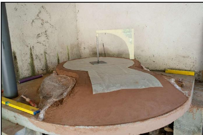
Pose d'un plastique de protection de diamètre légèrement inférieur au diamètre interne du four.
