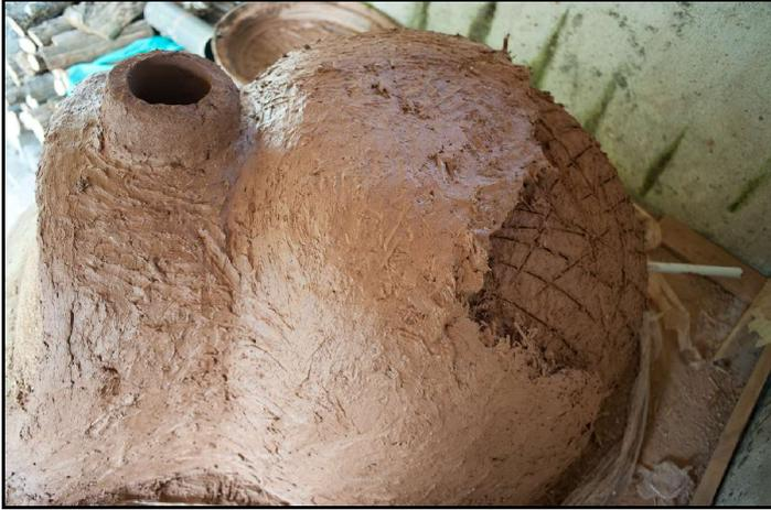
Sur cette image on aperçoit un tube qui sort à l'arrière du four. Je l'ai mis en place au moment de commencer la première couche. Il sera retiré quand toutes les couches seront mises. Ainsi le four aura une entrée d'air si nécessaire.
